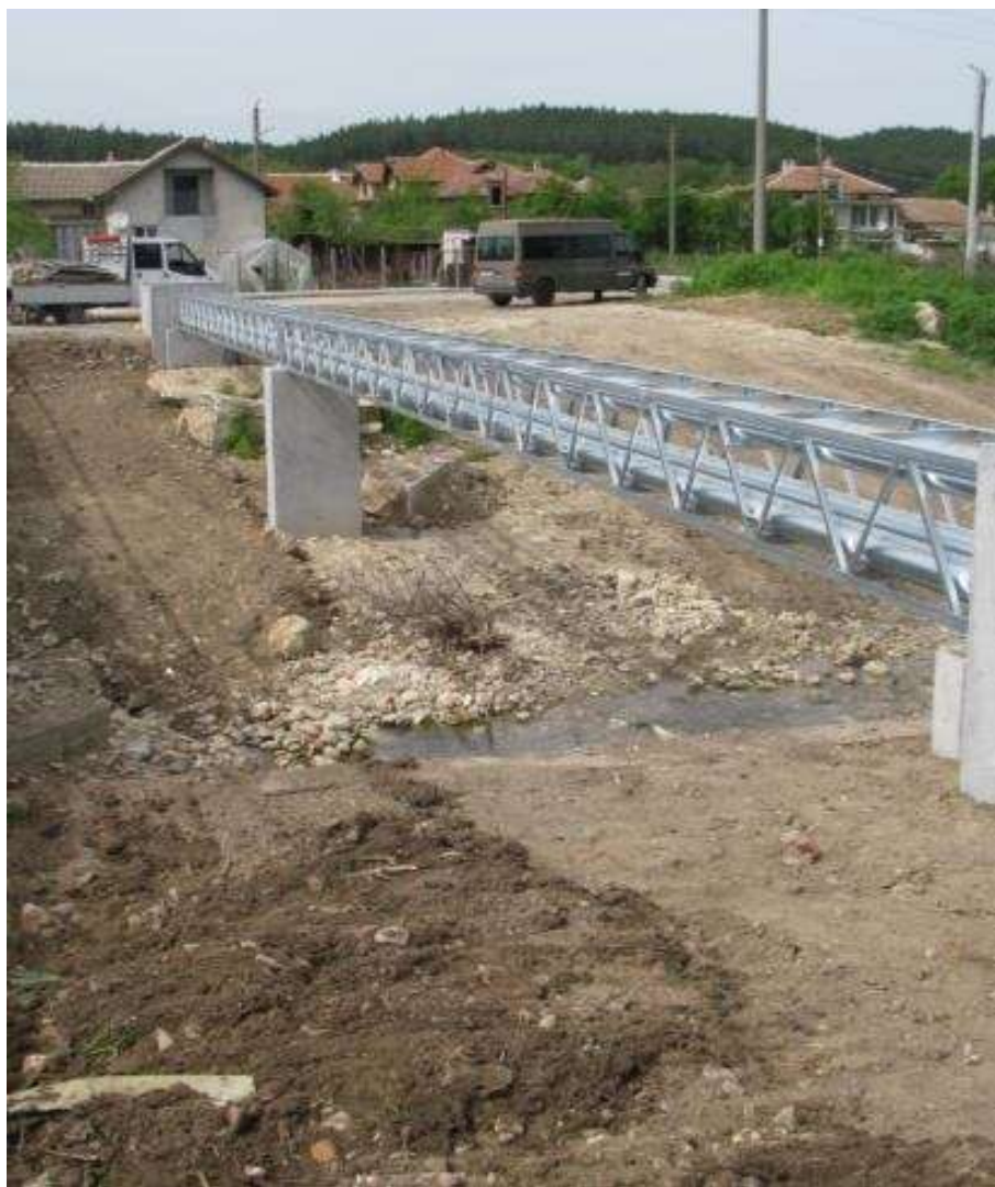
Пасарелка за преминаване на подземни кабелни линии над река
