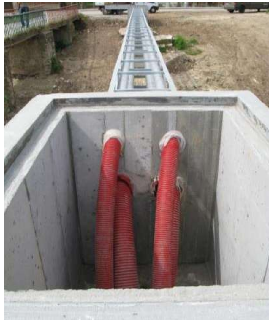
Преход на подземни кабелни линии
