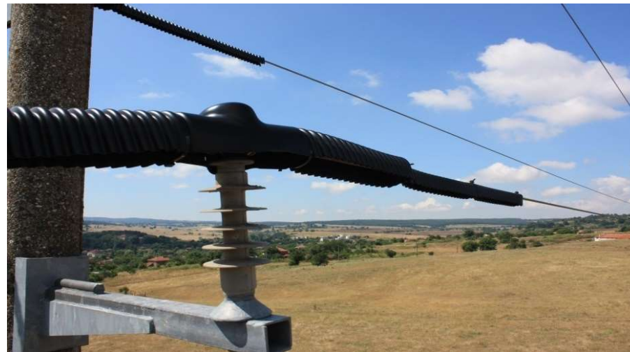
Монтирани защитни изолации
